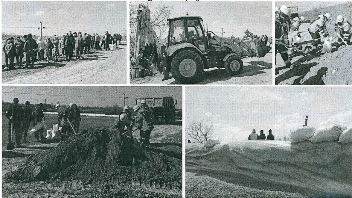
Figura 8. Activități de întărire a digului
